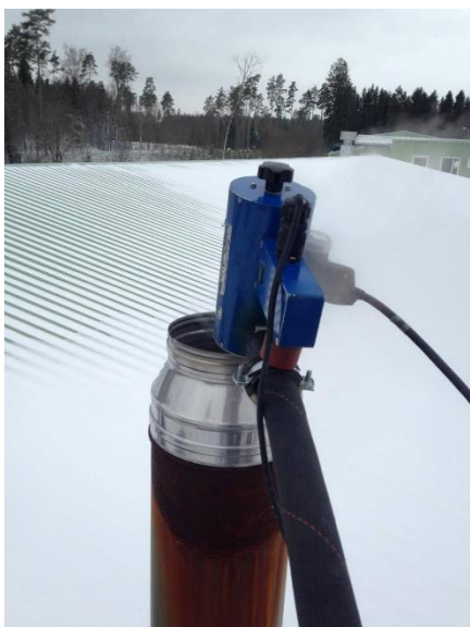
Pilt 2.3. Väätša prügila kompressorjaama põleti mõõtmiste ajal.
