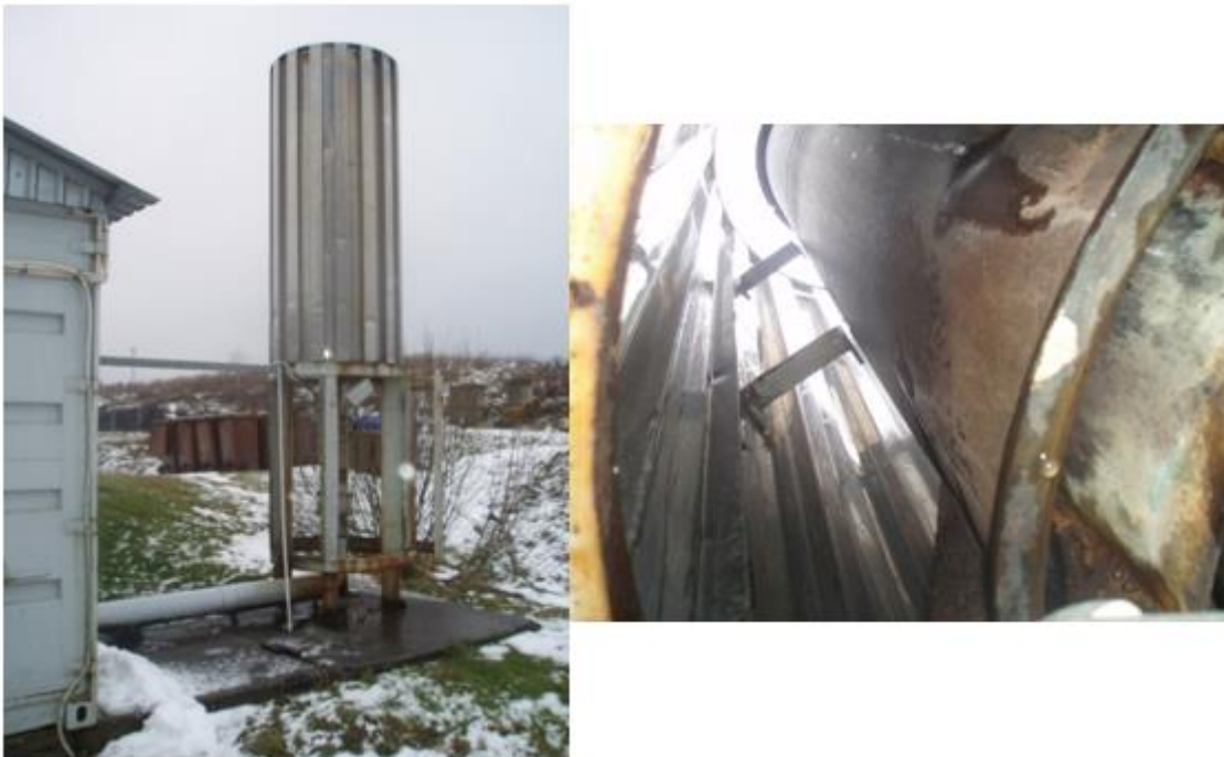
Pilt 2.2. Väätsa prügilagaasi välisisolatsiooniga kaetud põleti.
