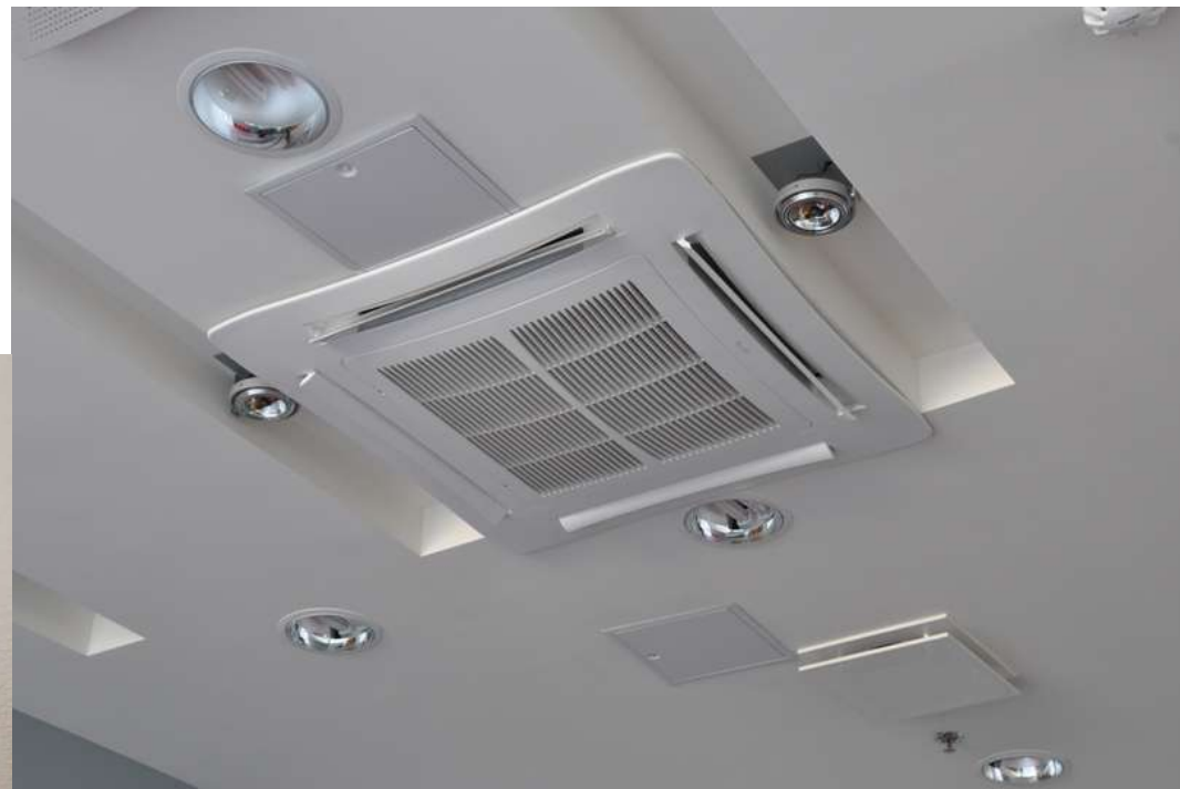
Tammsaare ärikeskusesse ruumide jahutamiseks paigutatud AlpicAir'i veekassetid
