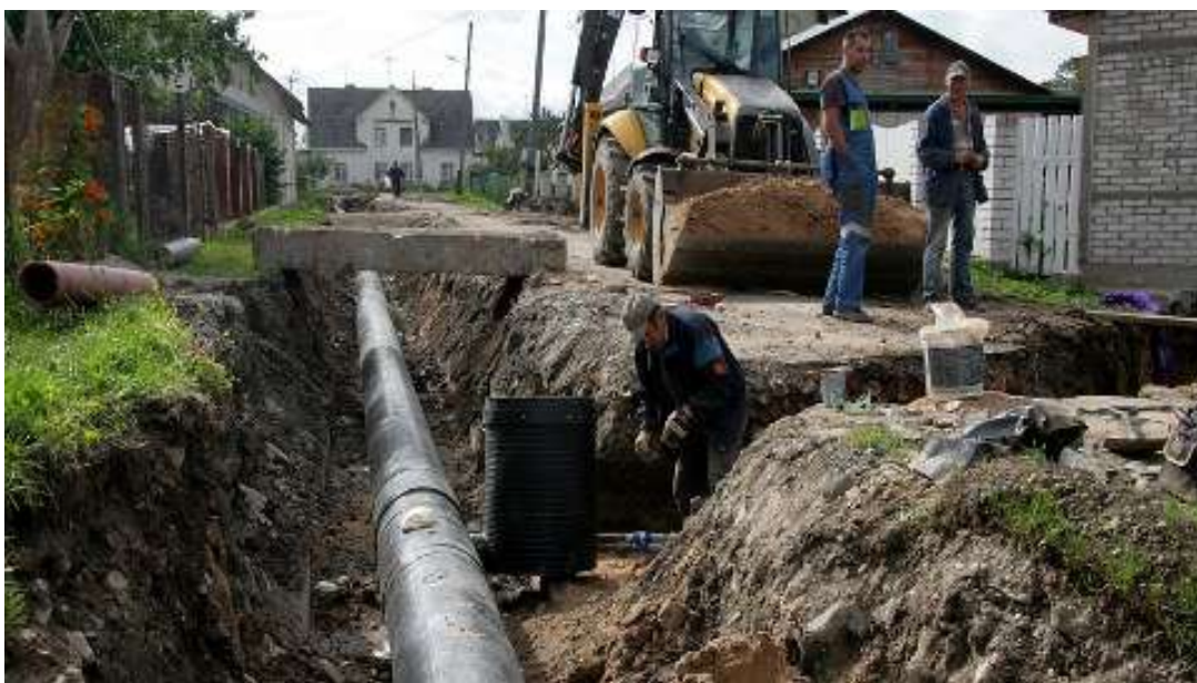
Foto: Sompä soojustrassi paigaldamine 2012, pr.pohjarannik.ee
