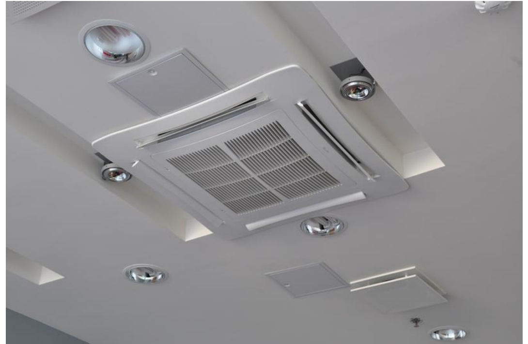
Tammsaare ärikeskusesse ruumide jahutamiseks paigutatud AlpicAir'i veekassetid
