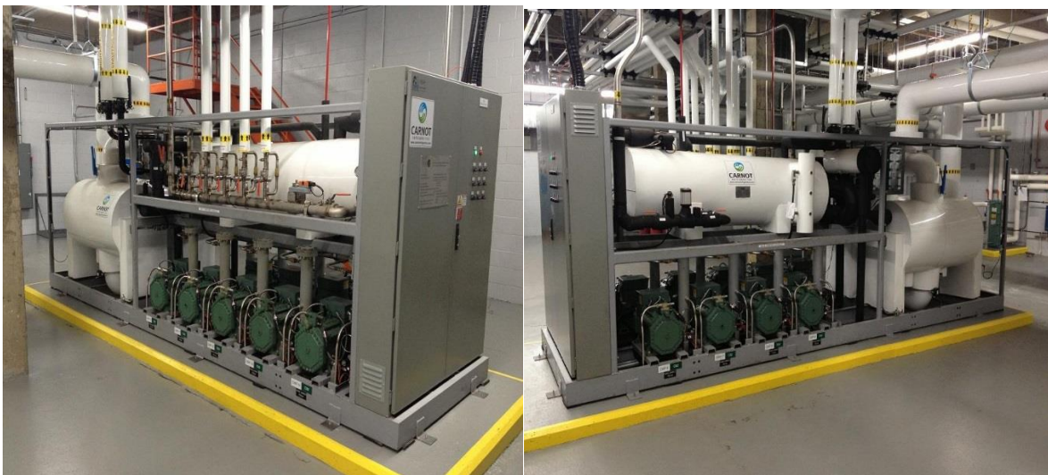
Joonis 13. CO 2 komplektne külmajaam
