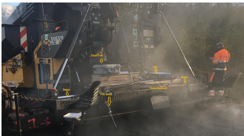
Joonis 21 Mõõtmisprotsess ja analüsaatorid laoturul
