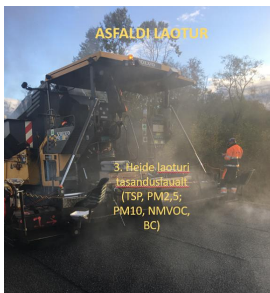
Joonis 20 Laoturi tasanduslaud ja heide
